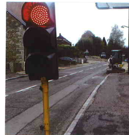
Travaux au croisement des RD3 et RD474
