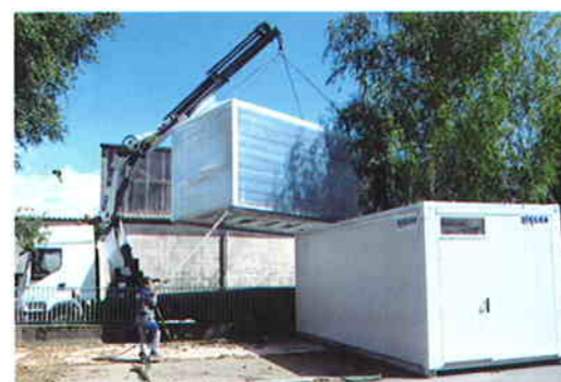
Changement de l'Algeco à l'école
