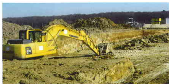
Travaux de création d'une déchetterie
