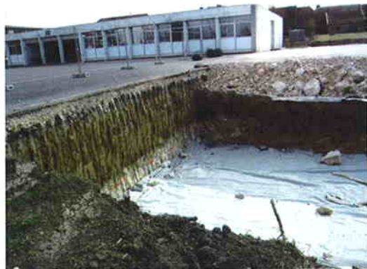
Création d'un nouveau centre périscolaire en cours
